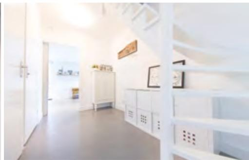
Beton-Ciré Gussboden zeichnet sich durch hervorragende Eigenschaften aus: Er ist nachhaltig und langlebig, kratz- und abriebfest, nahtlos, wasserdicht, eignet sich für Fußbodenheizungen und ist außerdem sehr pflegeleicht.
